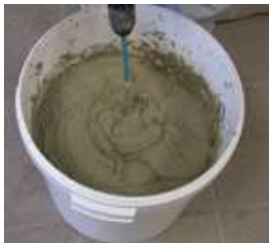
Der Mörtel wird mit einem Rührwerk angemischt. Komp. A + B in einen 30 l Kübel geben und 2 min. gut durchmischen- fertig.
